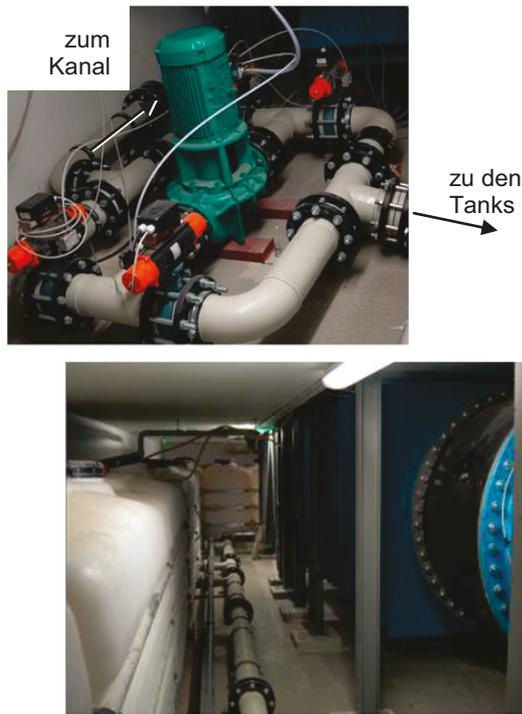
BILD 8. Weitere Elemente der Sekundärtechnik: Die Befüll- und Entleer-Einheit (oben) und der Keller mit den Puffertanks (unten)
